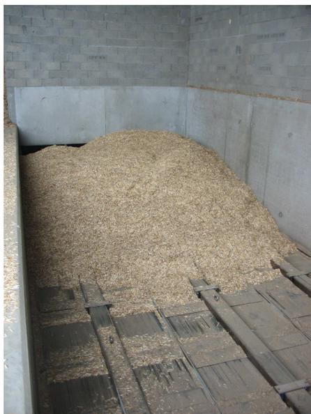
Photo 9 : Vue des échelles racleuses recouvertes par du *Miscanthus* ensilé (Source : Pôle énergie CA 47)
