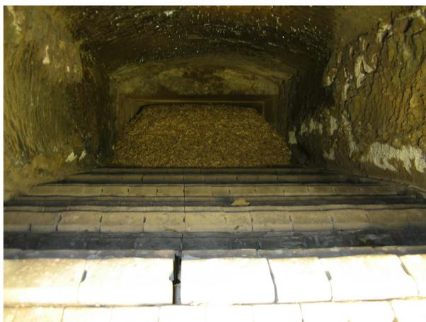
Photo 11 : Vue du foyer et des grilles mobiles avec dans le fond du *Miscanthus* (Source : Pôle énergie CA 47)
